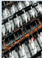
Batteries au lithium
